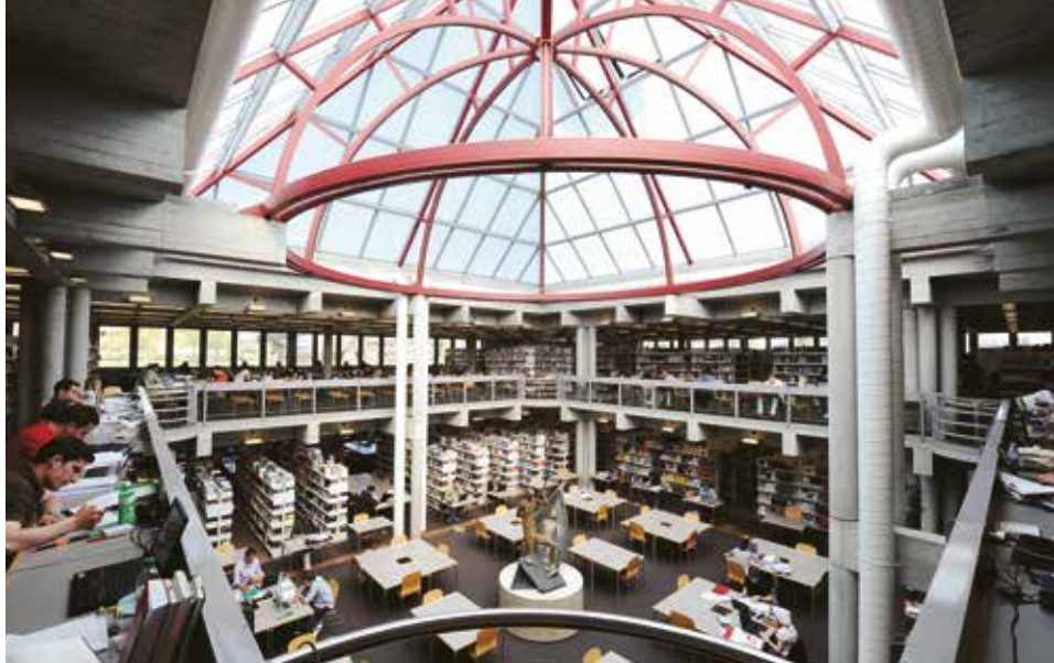
Unter der grossen Glaspyramide und einer kuppelförmigen Stahlträgerkonstruktion befindet sich die Bibliothek
