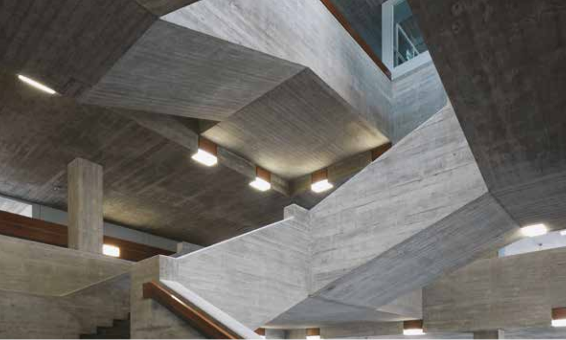
Imposant und skulptural. Die freitragende Betontreppe in der grossen Halle des Hauptgebäudes
