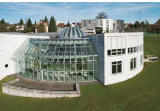
Ostfassade des Weiterbildungszentrums (WBZ) auf der Holzweid
